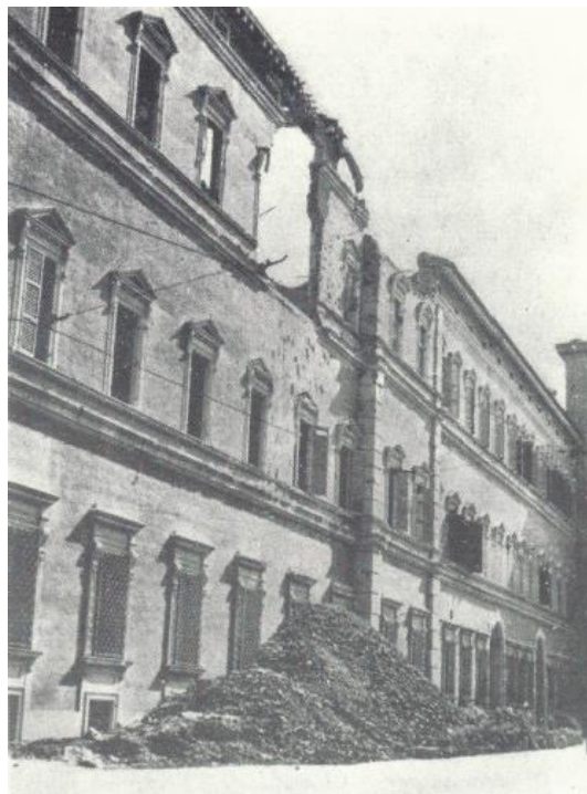
Bombardamento aereo 1944 : danni al Palazzo Ducale sul lato Via 3 Febbraio
